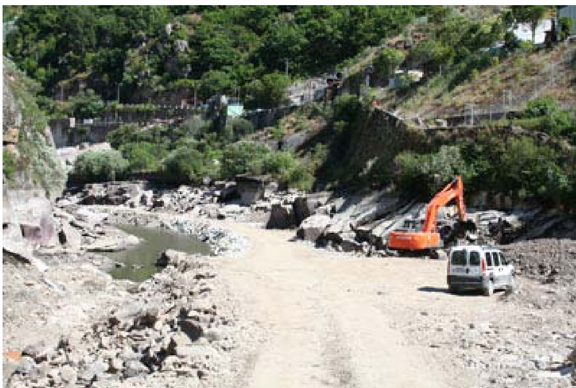
Pista construída con cascallos sobre o cauce do río Sil (14-07-09)
