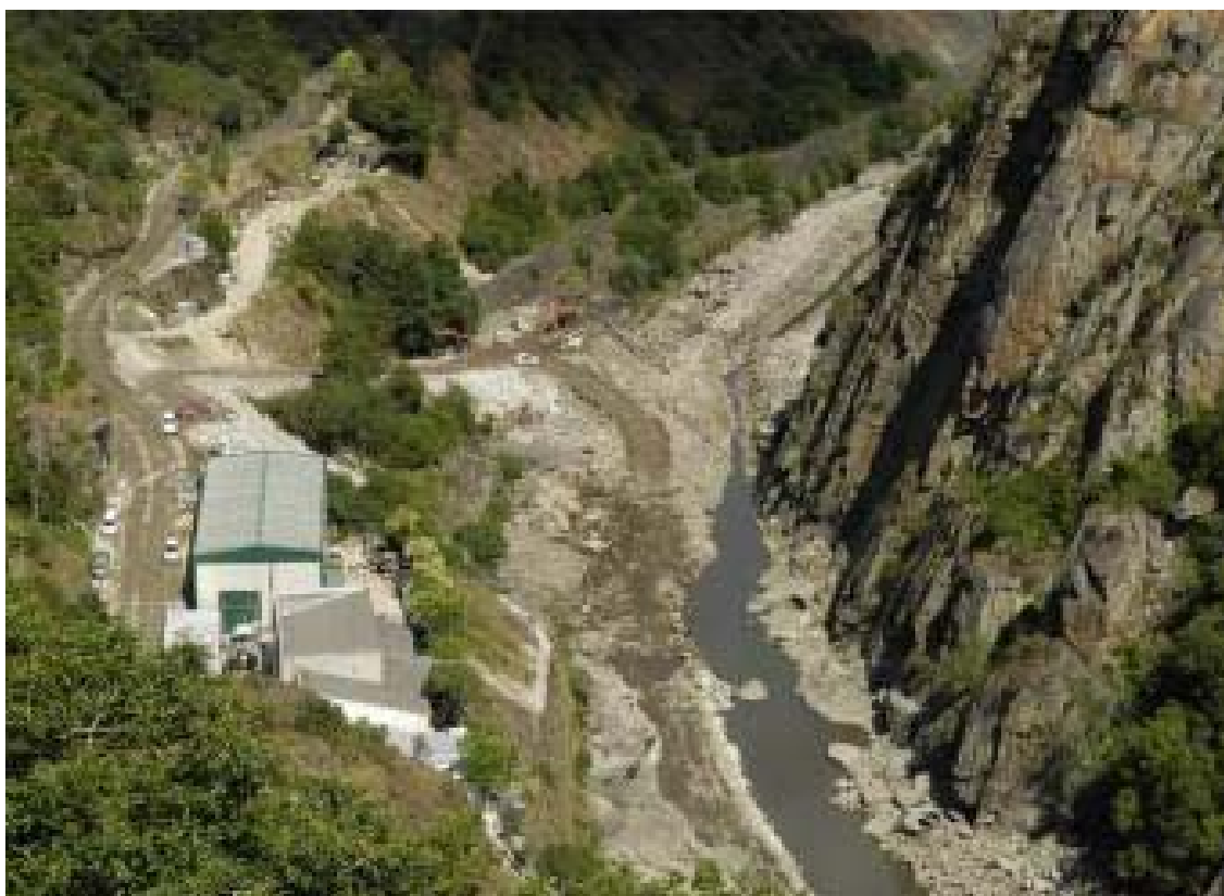
Cauce do río Sil despois do comenzo das obras (14-07-09)
