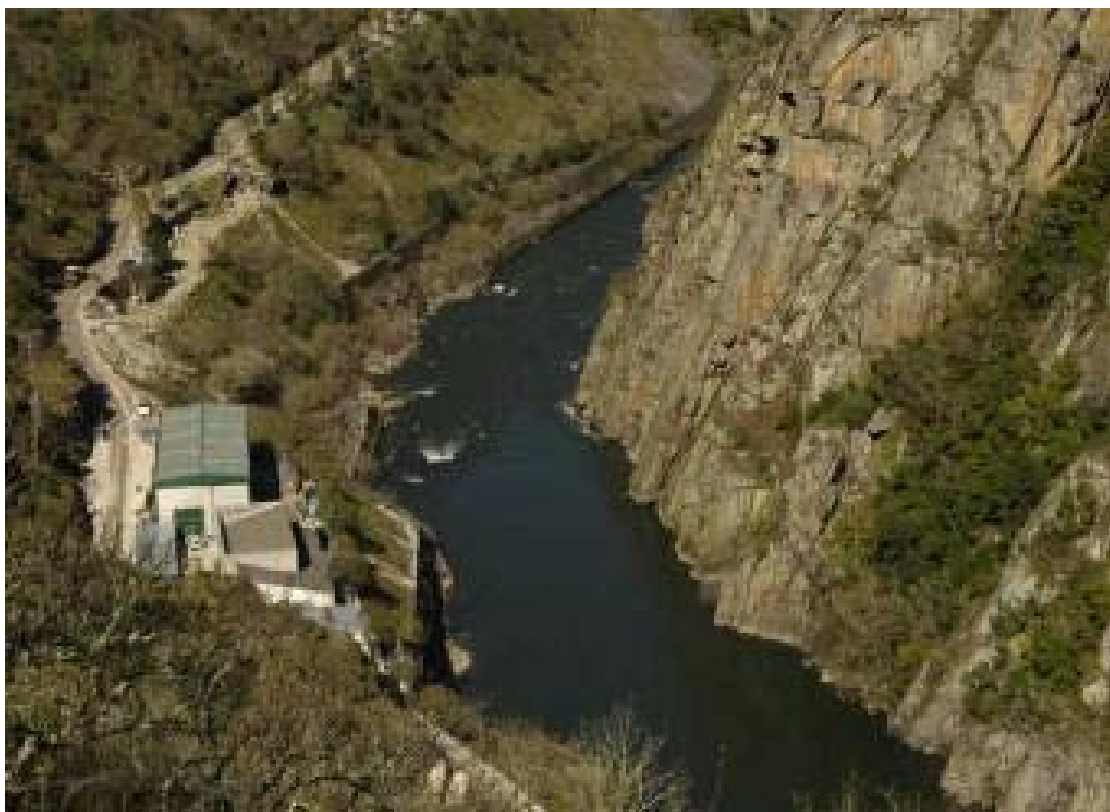
Cauce do río Sil antes do comenzo das obras
