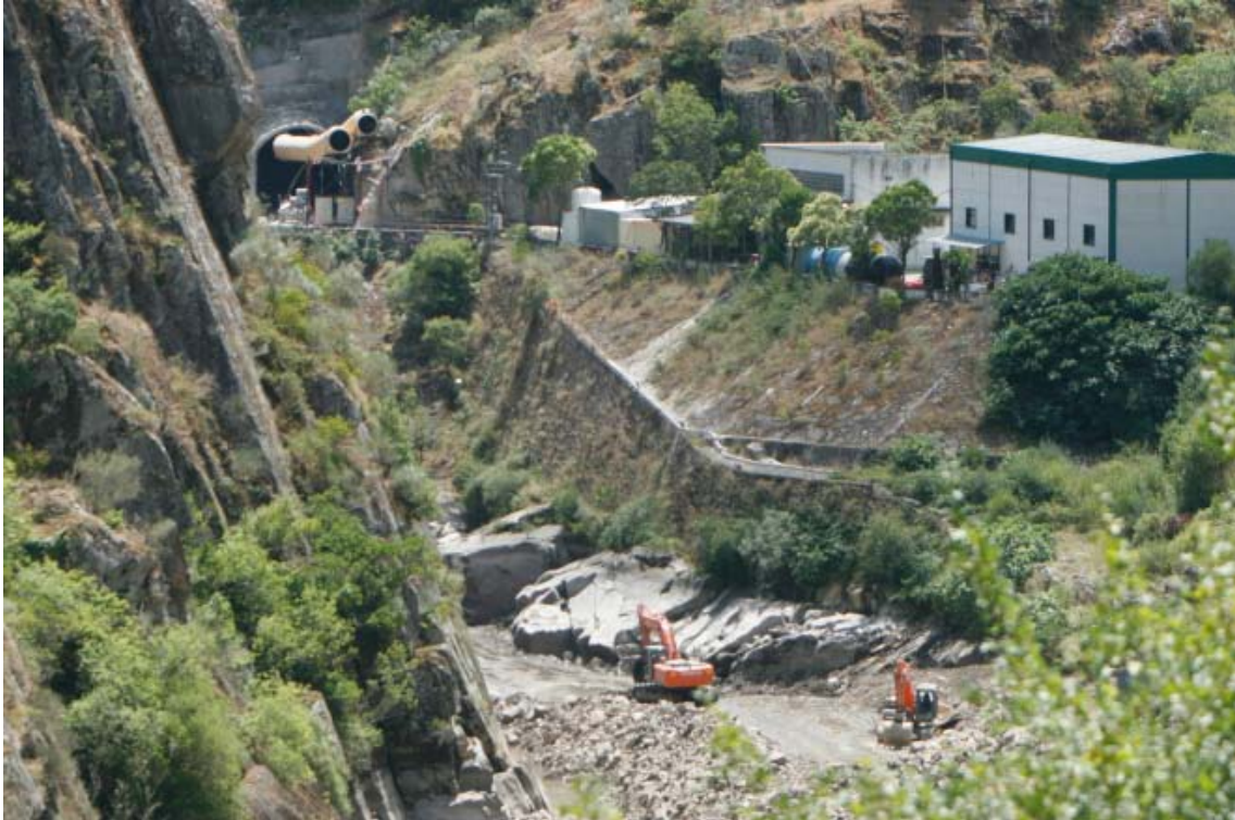
Boca do tunel que se estaba construíndo (14-07-09)
