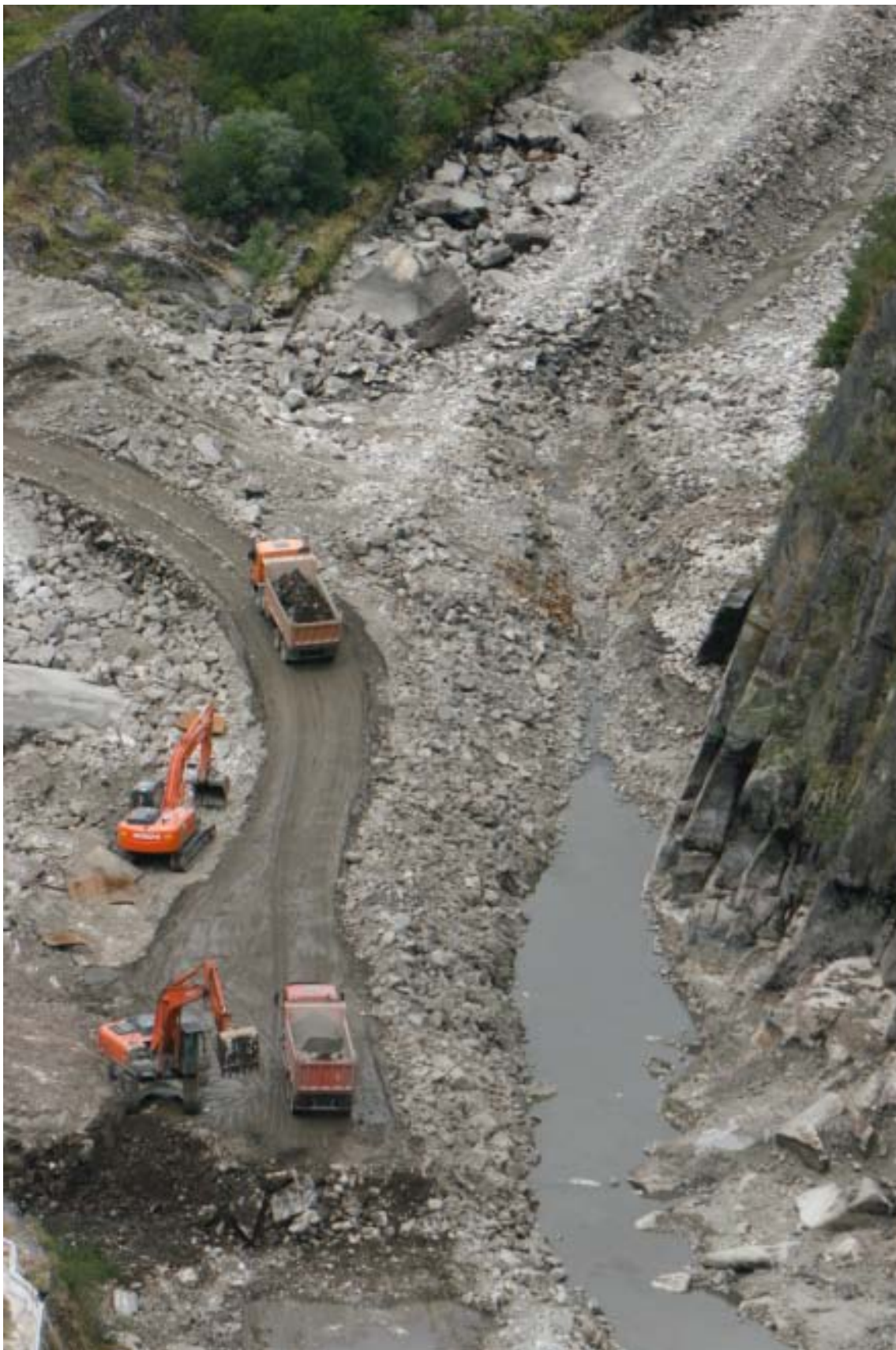
Maquinaria pesada na pista construída sobre o cauce do río Sil 14-07-09
